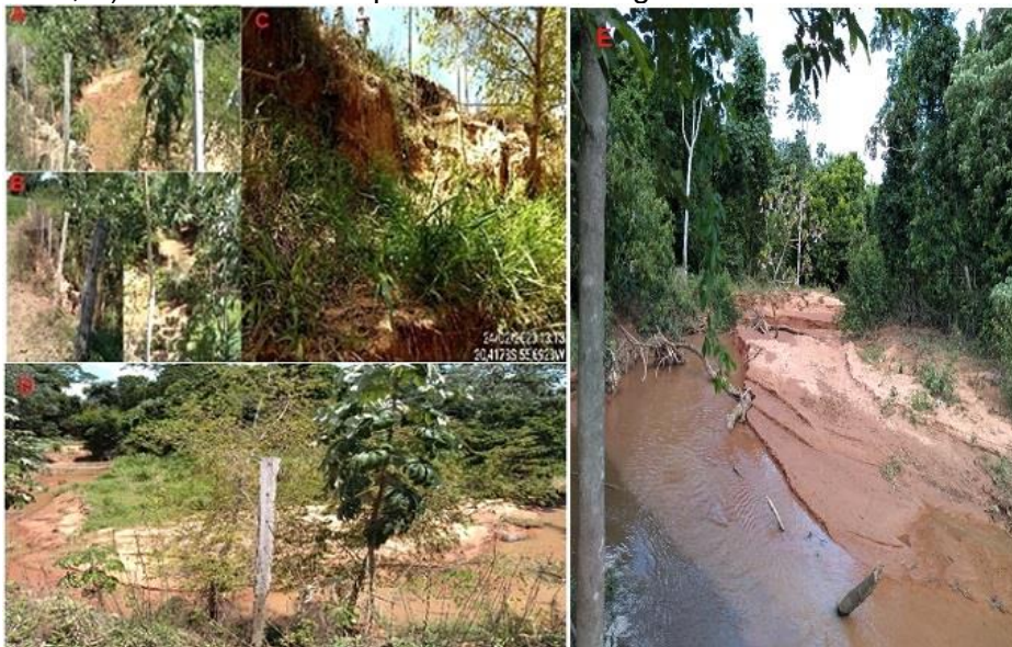
Figura 27. A, e B) Recuo da margem do córrego da Campina; C) vista de baixo; D) vista de cima; E) cerca derrubada pelo recuo da margem.
