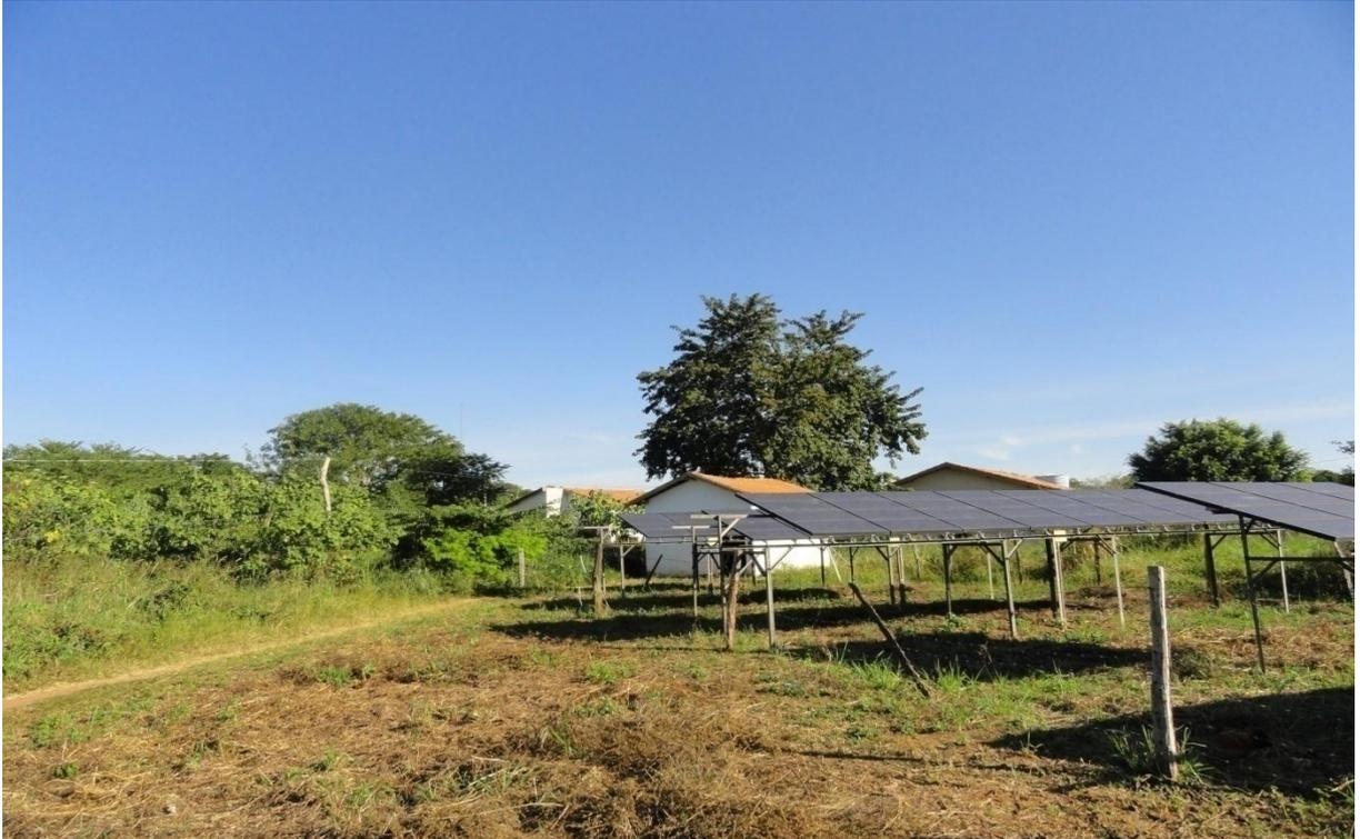
Figura 54: Placa solares e casa de baterias ao fundo.
