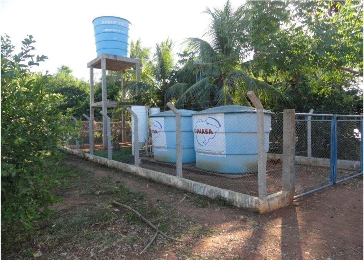
Figura 52: estação de tratamento de água.
