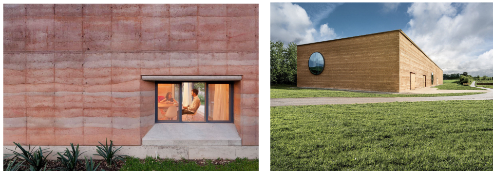
Figura 1. Edificações contemporâneas em taipa de pilão
