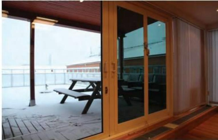
**Figura 6.** Escritório equipado com janelas eletrocromáticas em estados completamente claros e escurecidos.<sup>43</sup>
