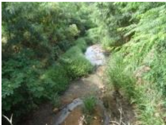
PONTO 5= Destamponamento da rede canalizada
