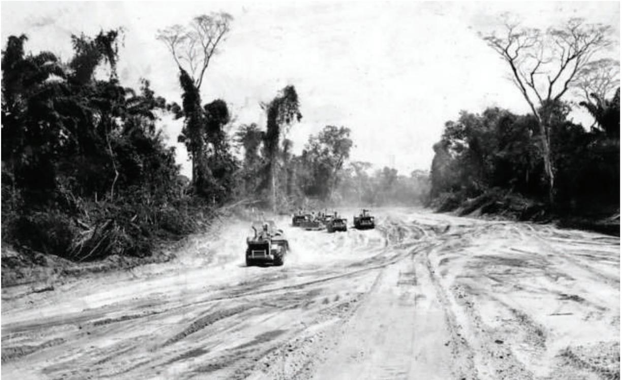
TRANSAMAZÔNICA – Tratores fazem terraplanagem em trecho da rodovia Transamazônica ainda em construção (Fonte: Folhapress).
