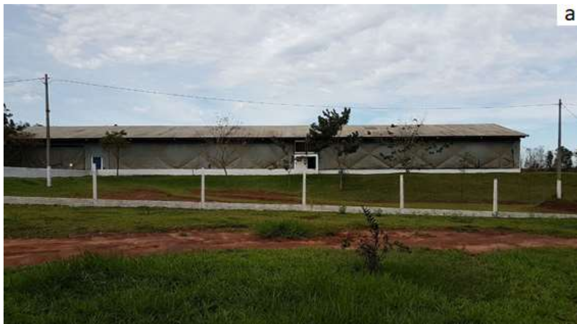
Figura 5 – Biossegurança das granjas de suínos. As granjas possuem cerca telada com altura de 2 metros permeando toda sua extensão. Há uma linha de tijolos rente ao solo para evitar escavação de animais. Próximo ao recinto dos animais existe uma nova barreira de cerca de quatro fios.
