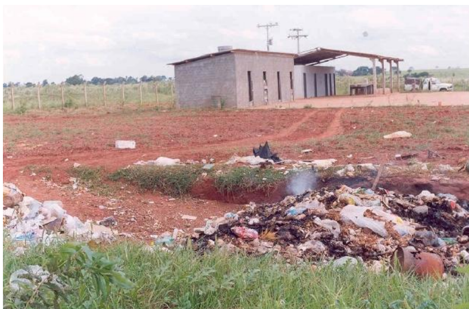
Figura 5.26 - Unidade de Processamento de Lixo – UPL em Japorã, MS.
