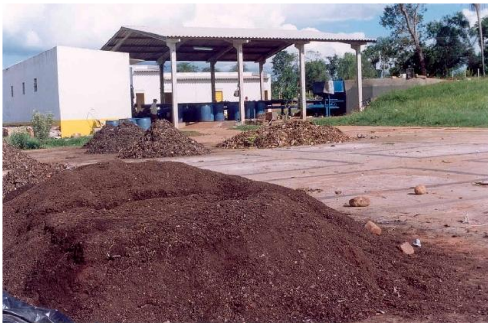
Figura 5.13 - Unidade de Processamento de Lixo – UPL em Jardim, MS.
