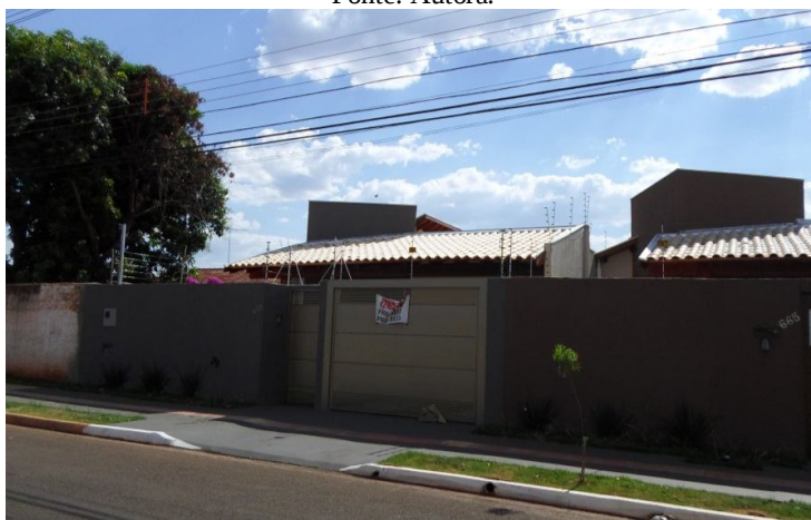
Figura 4: Imagem da edificação em CV e o entorno.
