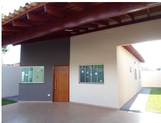
Figura 17: Vistas da edificação em CV.
