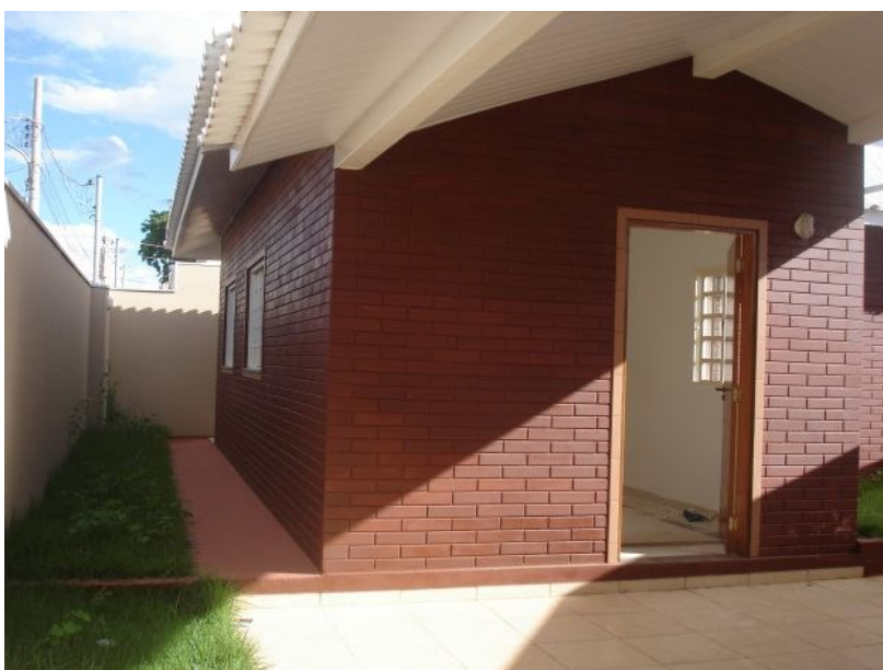
Figura 9: Vista da edificação em SC.
