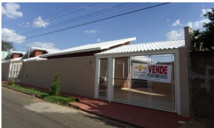
Figura 3: Imagem da edificação em SC e o entorno.
