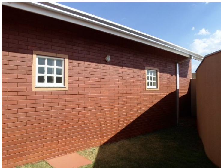
Figura 12: Vista externa da parede monitorada em SC.
