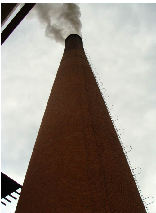
Figura 9 – Emissão de fumaça pela chaminé
