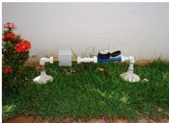
Figura 20 – Hidrômetros em série instalados no condomínio Golden Gate (ÁGUAS GUARIROBA, 2013).
