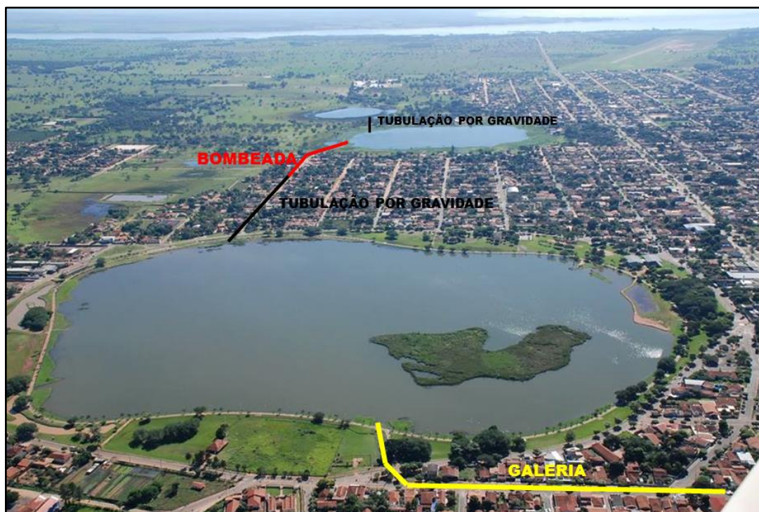
Figura 11: Sistema de drenagem das tubulações presente nas lagoas.
