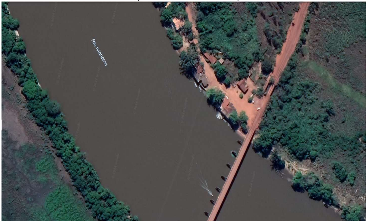
Figura 4 – Imagem do Google Earth sobre a ponte de madeira do Rio Ivinhema, fazendo alusão as construções em Área de Preservação Permanente
