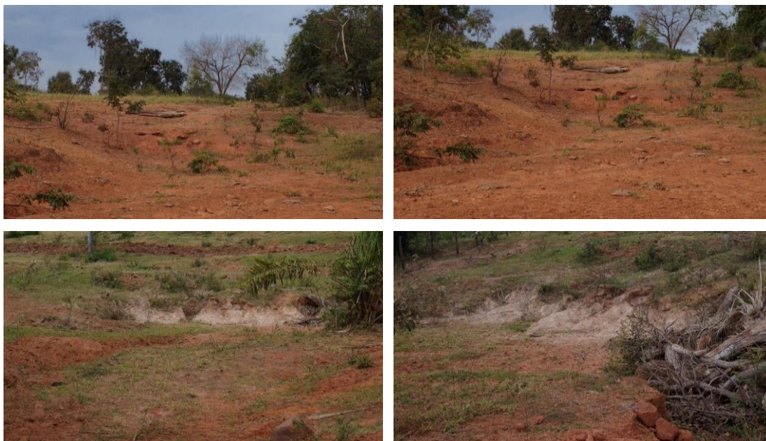
Figura 28: Área com início de feições erosivas ocasionadas pela remoção de vegetação na porção leste
