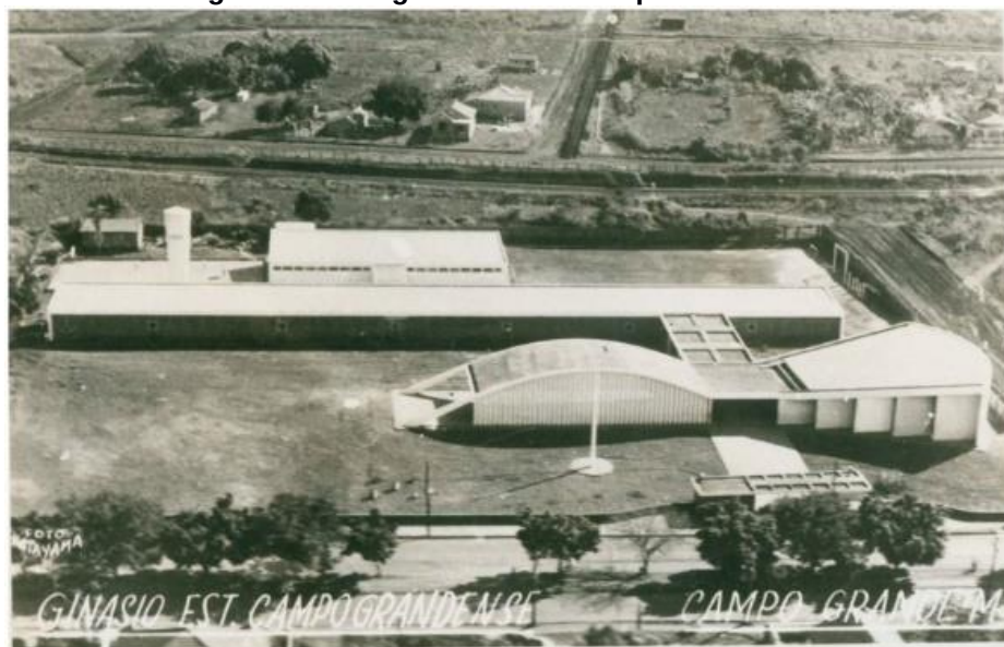
Figura 20: Colégio Estadual Campo-Grandense.
