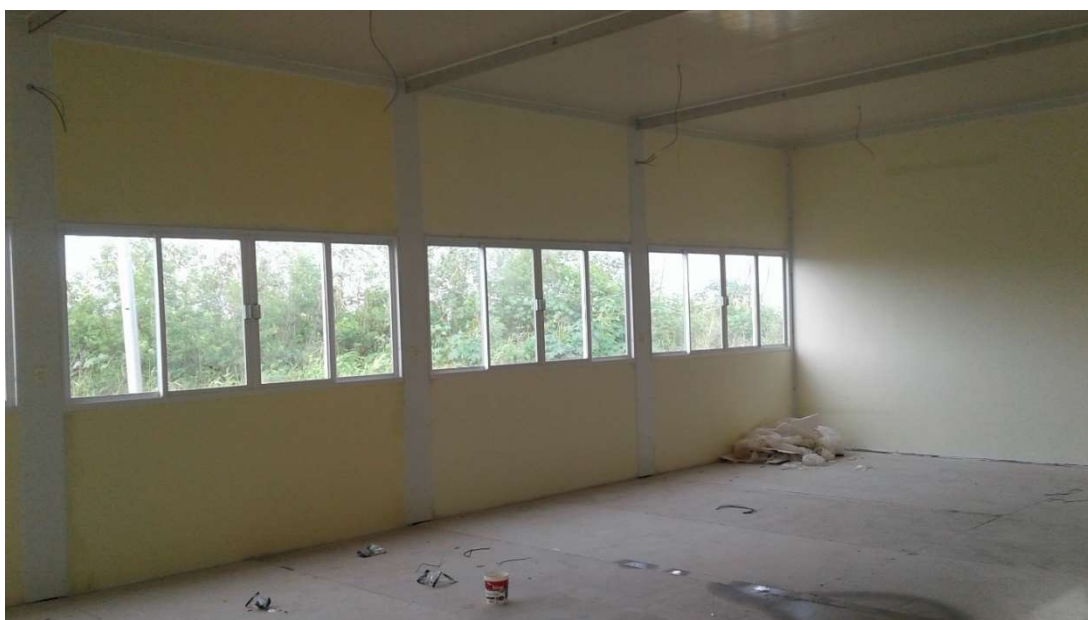
Figura 26 - Interior sala modular IFMS Campo Grande
