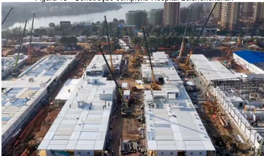
Figura 19 - Construção complexo Hospital Leishenshahan
